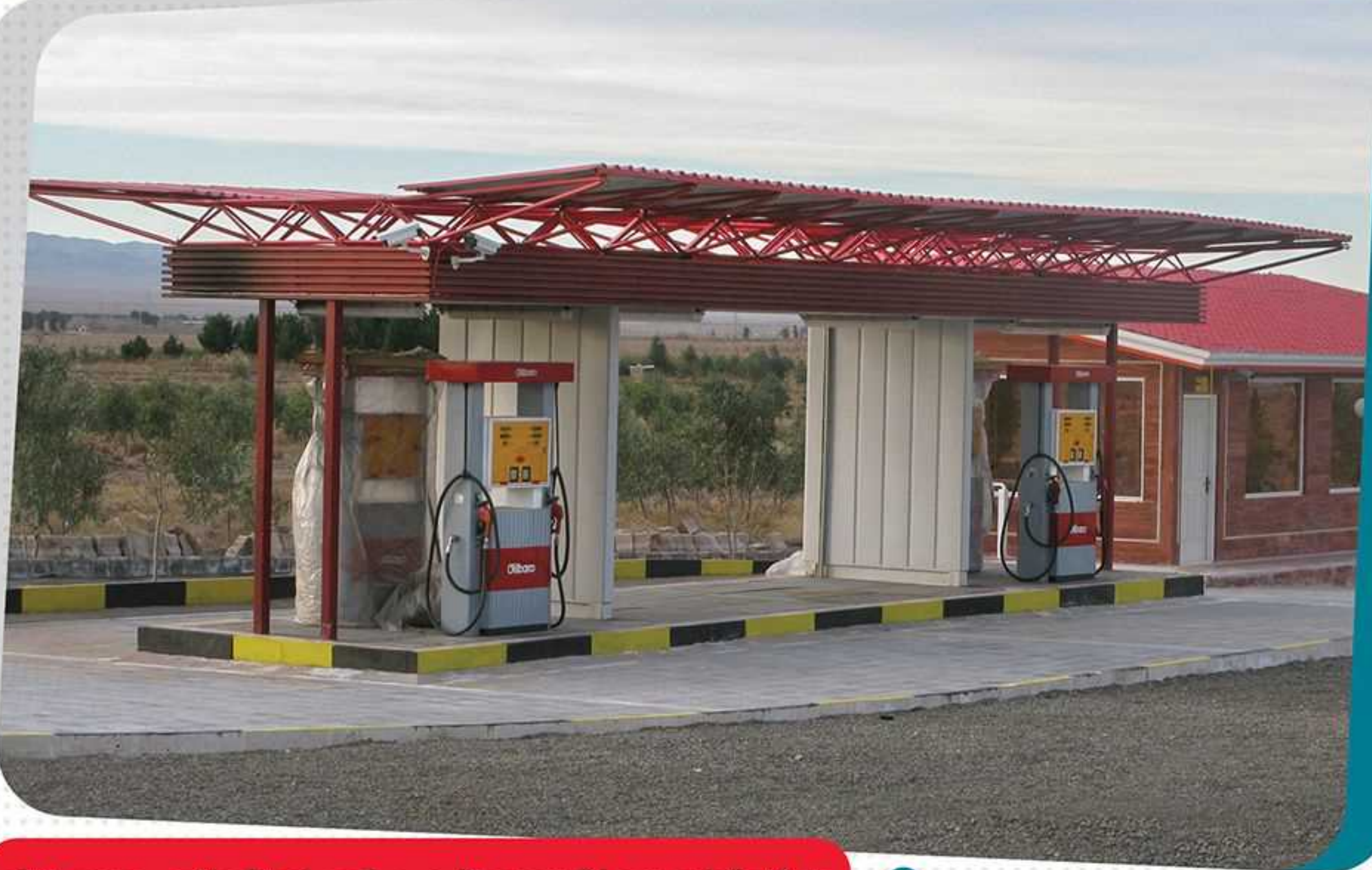
جایگاه توزیع سوخت سریع النصب مجتمع خدمات رفاهی پدیده کرانه
