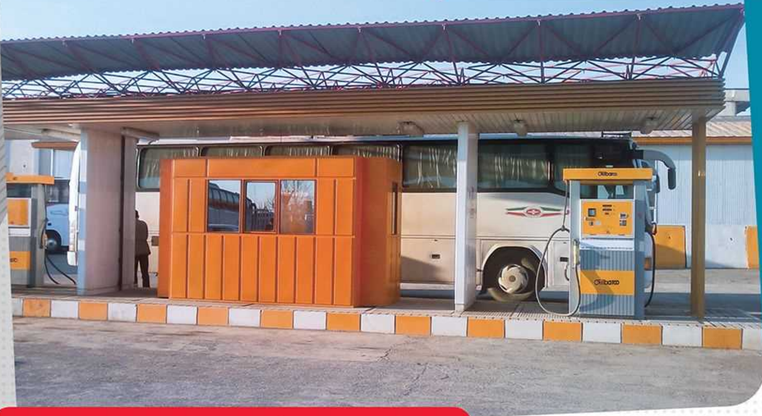
جایگاه توزیع سوخت سریع النصب پایانه مسافری
